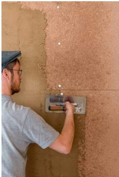
Innenwände mit Lehm zu gestalten, ist kinderleicht. Basis können Lehmplatten sein, die wie beim Trockenbau verarbeitet werden. Bild: tdx/Thermo Natur
