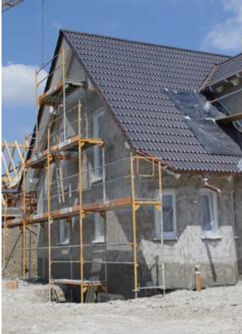
Arbeiten an Dach und Fassade sollten nicht ohne Gerüst angegangen werden. Bild: tdx/homesolute.com
