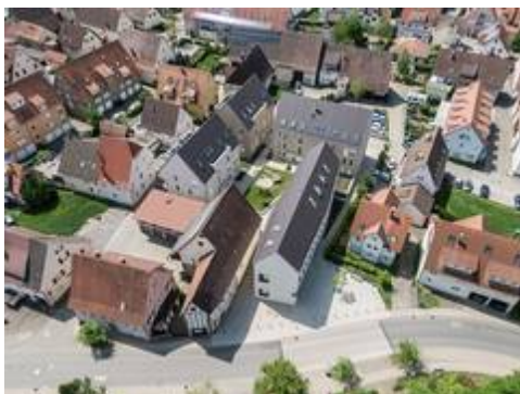
In einem einzigartigen Bauprojekt entstand mit dem Quartier Lange Gasse in Bondorf bei Böblingen nicht nur ein neues Wohn-Ensemble samt Bücherei und Gemeinschaftshaus, sondern vor allem ein moderner Dorfkern und Begegnungsort. Bild: Mein Ziegelhaus/Gerd Schaller
