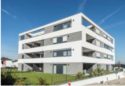
Mit einer dynamischen Form und ungewöhnlicher Linienführung hebt sich das Mehrfamilienhaus in Langenau vom langweiligen Einheitslook heutiger Bauten ab. Bild: tdx/Mein Ziegelhaus
