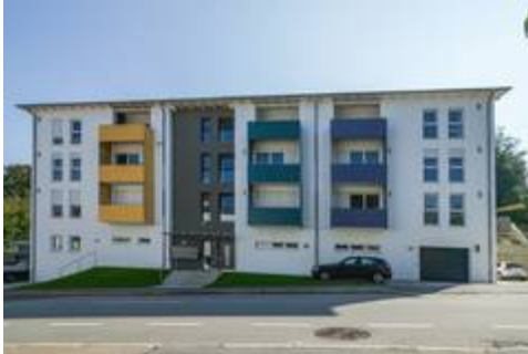
Attraktiv und zugleich zweckmäßig ist das Mehrfamilienhaus in Passau. Das in Hanglage gebaute Wohnhaus mit schlichtem Grundriss bietet Studenten und Familien eine attraktive Unterkunft. Bild: tdx/Mein Ziegelhaus
