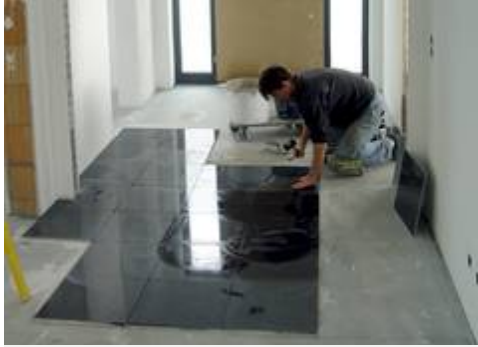
Fliesen in Küche und Bad kann der geübte Heimwerker selbst verlegen. Bild: tdx/themendienst
