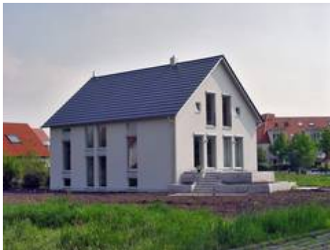
Bild: tdx/Mein Ziegelhaus
