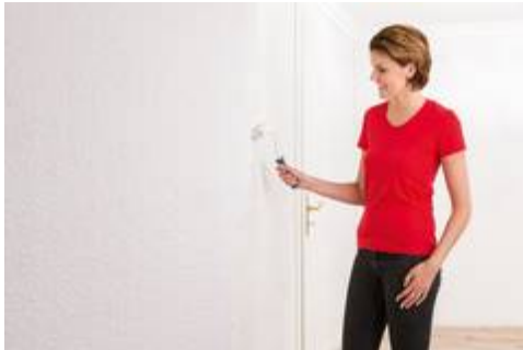
Im ersten Schritt wird die Spachtelmasse Einfach Glatt von Molto mit einem Roller direkt auf die Raufasertapete aufgetragen. Bild: tdx/Molto
