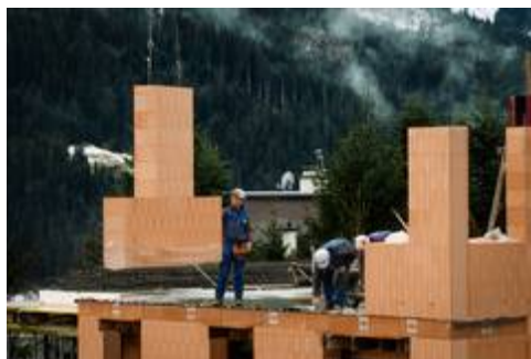
Hier kommt die Wand. Die Ziegel-Wandelemente werden einfach mit einem Kran ins Mörtelbett versetzt, anschließend mit Schrägstützen fixiert und die Stoßfugen mit Mörtel verschlossen. Bild: tdx/Hörl+Hartmann/Roland von Kummant
