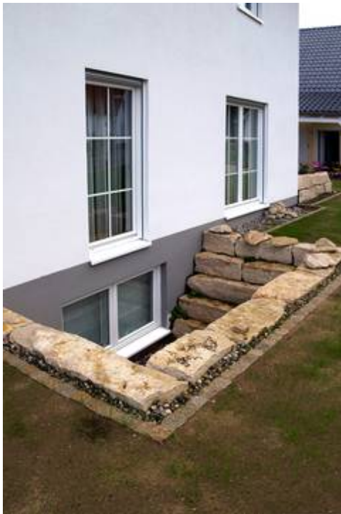
Die Mehrheit aller Hausbauer entscheidet sich für einen Keller. Die Vorteile liegen auf der Hand: mehr Raum für die individuellen Bedürfnisse. Bild: tdx/Mein Ziegelhaus
