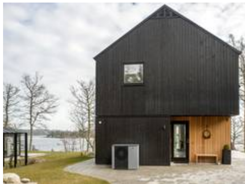
Luft-Wasser-Wärmepumpen können auch an sehr kalten Tagen der Umgebungsluft so viel Energie entziehen, dass damit ein Einfamilienhaus problemlos beheizt werden kann. Bild: tdx/Nibe
