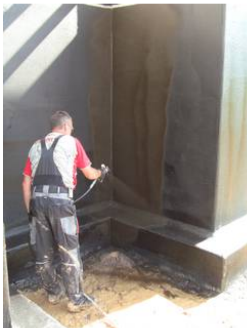
Keller sind erdberührende Bauwerke, in deren Außenwand sehr leicht Feuchtigkeit gelangen kann. Deswegen sollten Bauherren viel Wert auf eine zuverlässige und sichere Kellerabdichtung, wie die Bitumendickbeschichtung BORNIT-Profidicht 1K S, legen. Bild: tdx/Bornit
