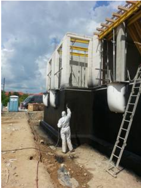
Dank moderner Spritztechnik und leicht zu verarbeitendem Material ist die BORNIT®-Profidicht 1K S Bitumendickbeschichtung bei vielen Bauvorhaben eine wirtschaftliche Alternative zur herkömmlichen Abdichtung mittels Bitumenbahnen. Bild: tdx/Bornit
