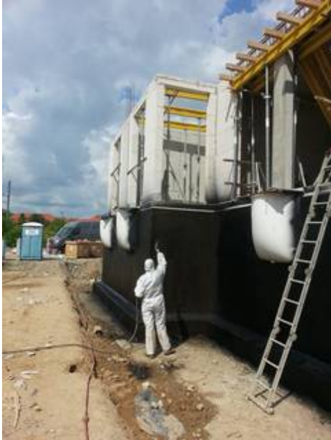
Dank moderner Spritztechnik und leicht zu verarbeitendem Material ist die BORNIT®-Profidicht 1K S Bitumendickbeschichtung bei vielen Bauvorhaben eine wirtschaftliche Alternative zur herkömmlichen Abdichtung mittels Bitumenbahnen. Bild: tdx/Bornit
