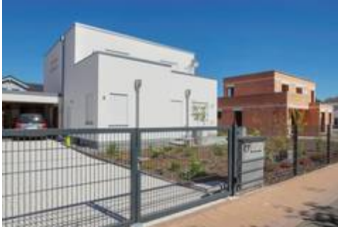
So kann perfekter Hitzeschutz aussehen: Massives Ziegelmauerwerk, heller Putz, ein vernünftiger Fensterflächenanteil mit außenliegender Verschattung und ein Gründach. Bild: tdx/Ziegelwerk Bellenberg
