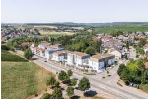
Ein bemerkenswertes Wohnquartier im Landkreis Heilbronn verbindet Generationen auf besondere Weise und wurde zudem für klimabewusstes Bauen ausgezeichnet. Bild: tdx/Mein Ziegelhaus/Gerd Schaller
