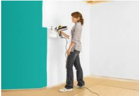
Farbsprühgeräte arbeiten effizient, sorgen für einen gleichmäßigen Farbauftrag, verkleben nicht und sind leicht zu reinigen. Bild: tdx/Wagner
