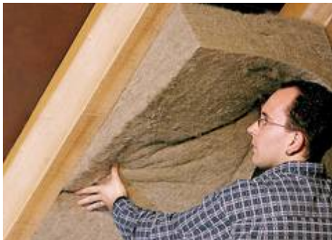
Materialien wie Holz, Hanf und Jute dämmen ähnlich gut, wie Polystyrol, Glas- und Steinwolle. So greifen Bauherren zunehmend zu natürlichen Alternativen. Bild: tdx/Thermo Natur
