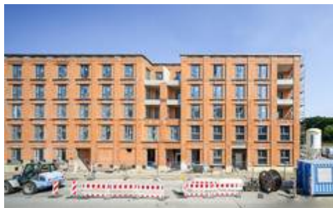
Ein „echter“ Ziegelrohbau mit homogenem Putzuntergrund. Bild: tdx/Hörl & Hartmann/Gerd Schaller
