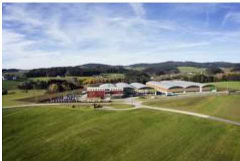
Der Firmensitz von ÖkoFEN in Niederkappel/AUT wird durch den Neubau (rechts im Bild) auf insgesamt 13.500 m 2 erweitert. Bild: tdx/ÖkoFEN
