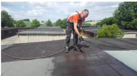
Ein Voranstrich dient dazu, die Hafteigenschaft zu verbessern, indem lose Bestandteile wie Staub gebunden und unterschiedliches Saugverhalten ausgeglichen werden. Der BORNIT®-Speedbit-Primer dringt tief in den Untergrund ein und überzeugt durch seine sehr schnelle Trocknung. Er haftet auf vielen bauüblichen Untergründen wie Beton, Putz, Holz, Ziegel, Stein, Metallen und Bitumenbahnen. Bild: tdx/Bornit
