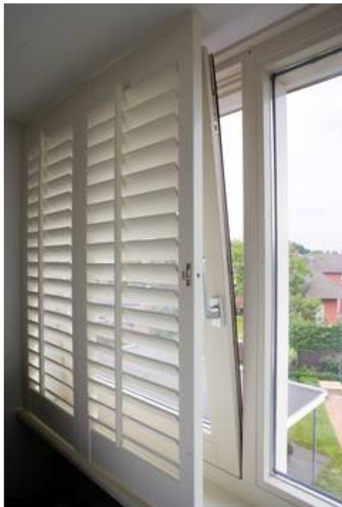
In tiefen Fensterlaibungen können Shutters hinter dem Fenster montiert werden. Shutterpaneele und Fensterflügel bewegen sich dann getrennt voneinander. Soll das Fenster komplett geöffnet werden, schiebt man die Shutters einfach beiseite. Soll nur gekippt werden, bleiben die Shutters an ihrem Platz. Bild: tdx/JASNO
