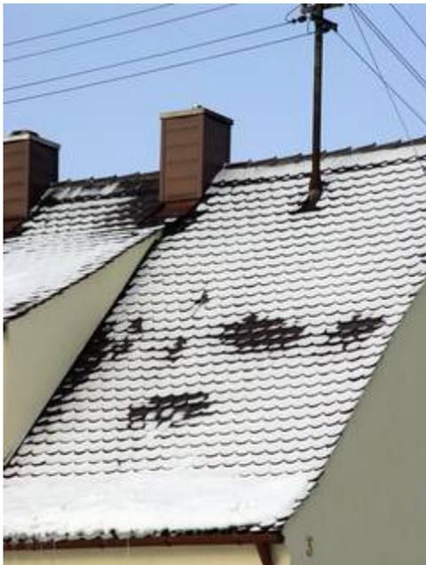
Dämmlecks werden bei Schnee auf dem Dach deutlich sichtbar. Bild: tdx/homesolute.com
