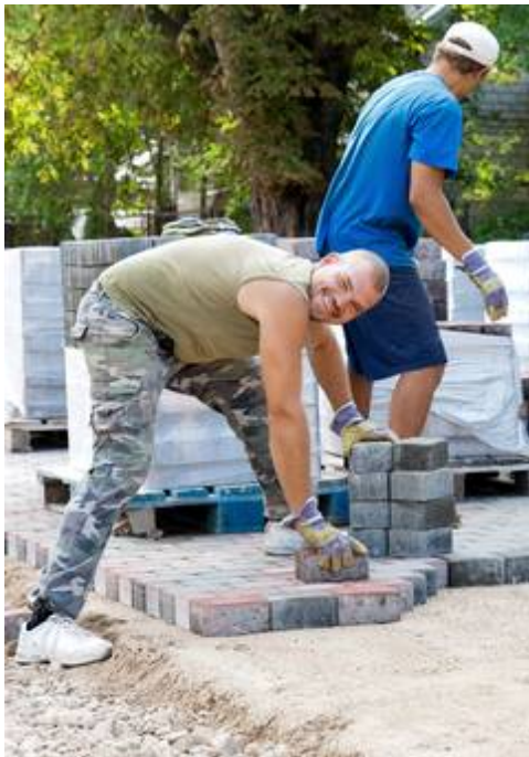
Je nach Verlegemuster wird Stein für Stein in die vorbereitete Bettung aus Sand, Kies oder Splitt gesetzt. Bild: tdx/aigarsr/Fotolia
