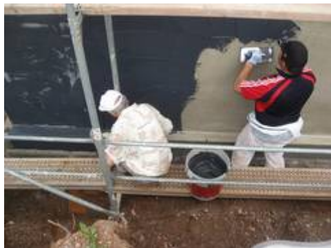
Bornit-Profidicht Hybrid 2K ist für den Einsatz auf waagerechten und senkrechten Flächen geeignet und lässt sich zügig und materialsparsam auftragen. Bild: tdx/Bornit
