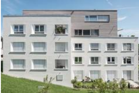
Wohnanlage Lindenberg Bild: Mein Ziegelhaus / Gerd Schaller
