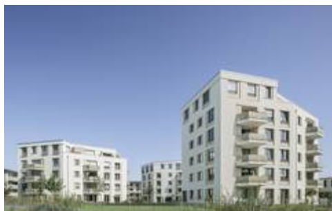
Bis zu sechs Vollgeschosse hoch sind die Gebäude des Kemptner Wohnparks „Stiftsstadt-Wohnen“. Errichtet in monolithischer Massivbauweise mit speziell für den Geschosswohnungsbau entwickelten Ziegeln von Mein Ziegelhaus. Bild: tdx/Gerd Schaller/Mein Ziegelhaus
