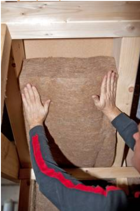
Das Dämmen ist eine zentrale Frage beim Bauen und Sanieren. Leistungsstarke Dämmstoffe aus nachwachsenden Rohstoffen entwickeln sich in vielen Bereichen zur bevorzugten Lösung. Sie tragen zu einem wohngesunden Lebensumfeld bei und reduzieren Energieverbrauch sowie CO 2 -Emissionen. Bild: tdx/Thermo Natur
