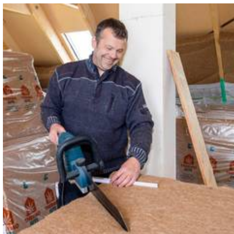
Thermo Jute 100 Plus ist als Matten- und Rollenware sowie in Maßanfertigungen erhältlich. Damit ist er wie herkömmliche Dämmstoffe einfach zu verarbeiten. Das Zuschneiden erfolgt mit bewährten Geräten, zum Beispiel einem elektrischen Fuchsschwanz. Bild: tdx/Thermo Natur
