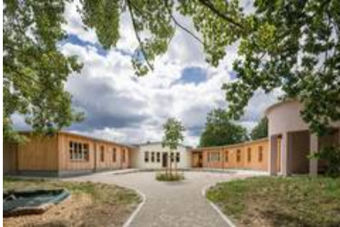
Der Innenhof des Kindergarten in Schwäbisch Hall bietet viel Platz zum Toben. Bild: Mein Ziegelhaus / Gerd Schaller
