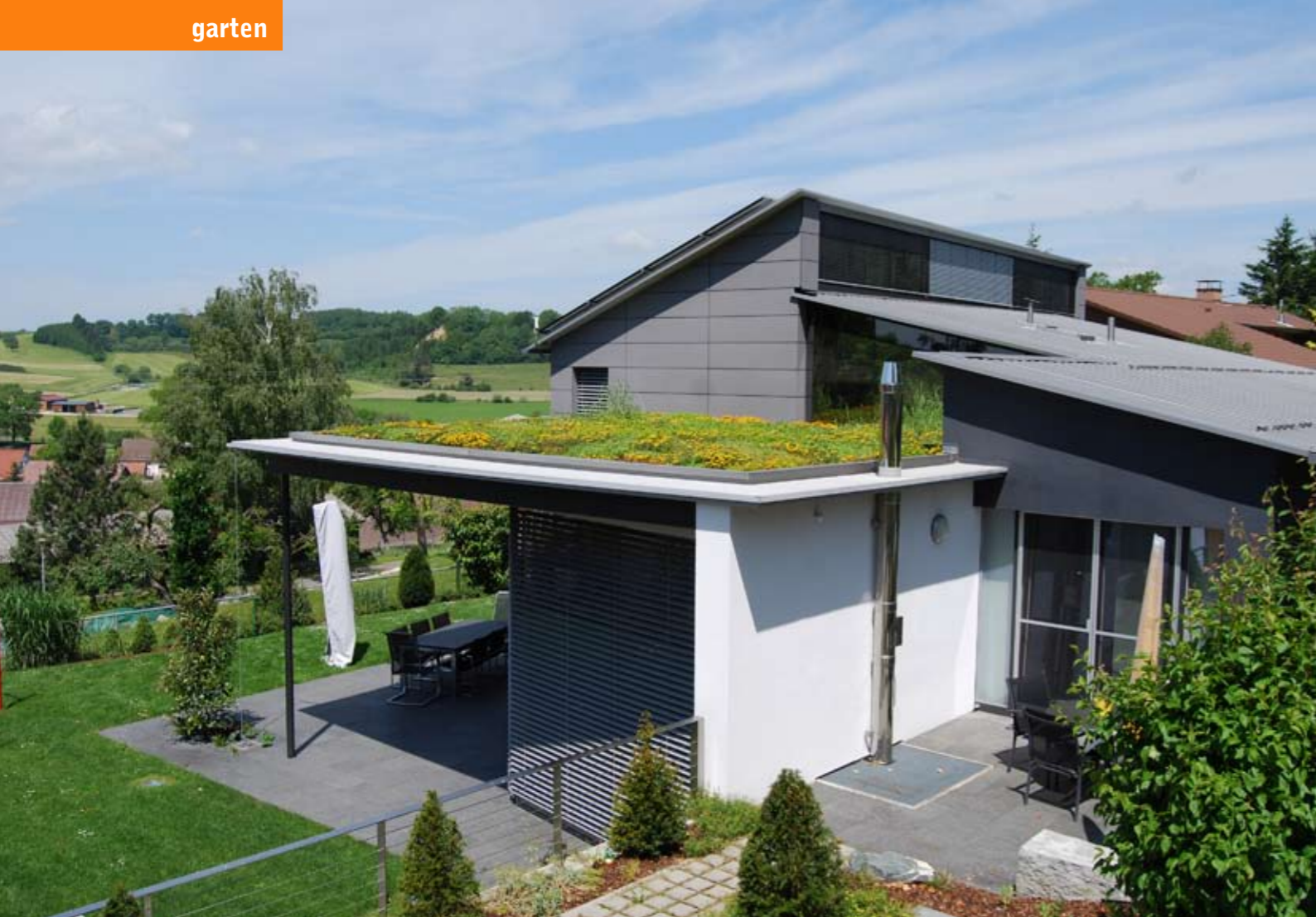
BU: Eine Dachbegrünung schützt das Dach nachhaltig und verbessert nebenbei den Wärme-, als auch den Schallschutz. Bild: tdx/Optigrün
