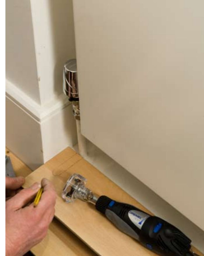
BU: Auf dem Paneel werden zuerst die Maße des Heizungsrohrs mit einem Bleistift markiert. Mit dem Dremel und dem Kreissäge-Vorsatz wird der Materialstreifen entlang der parallelen Markierungen ausgeschnitten.
