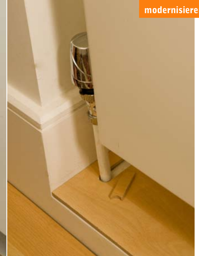
BU: Mit dem Mehrzweck-Fräsvorsatz wird ein Halbkreis im Durchmesser des Heizungsrohrs aus dem Paneel geschnitten. Zudem wird der gleiche Halbkreis in den abgetrennten Holzstreifen gesägt. Das Paneel kann jetzt um das Heizungsrohr geschoben und der Holzstreifen eingesetzt werden.
