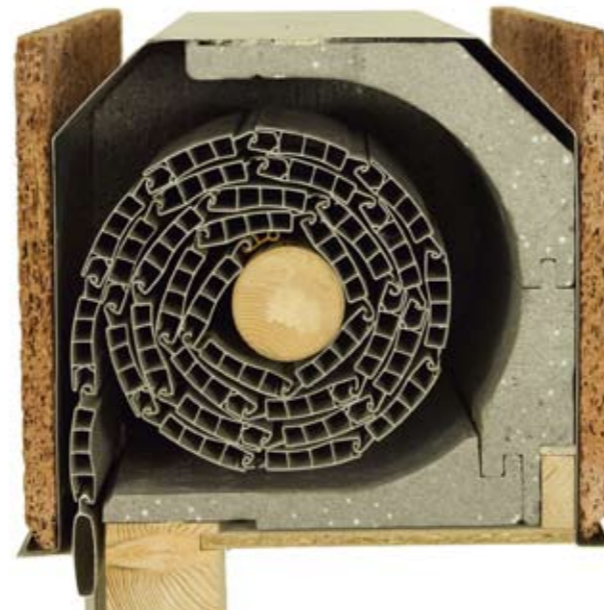
BU: Passgenaue und vollständige Rollladenkastendämmungen halten Wärme im Wohnraum und lassen Schimmel keine Chance. Bilder: tdx/DiHa
