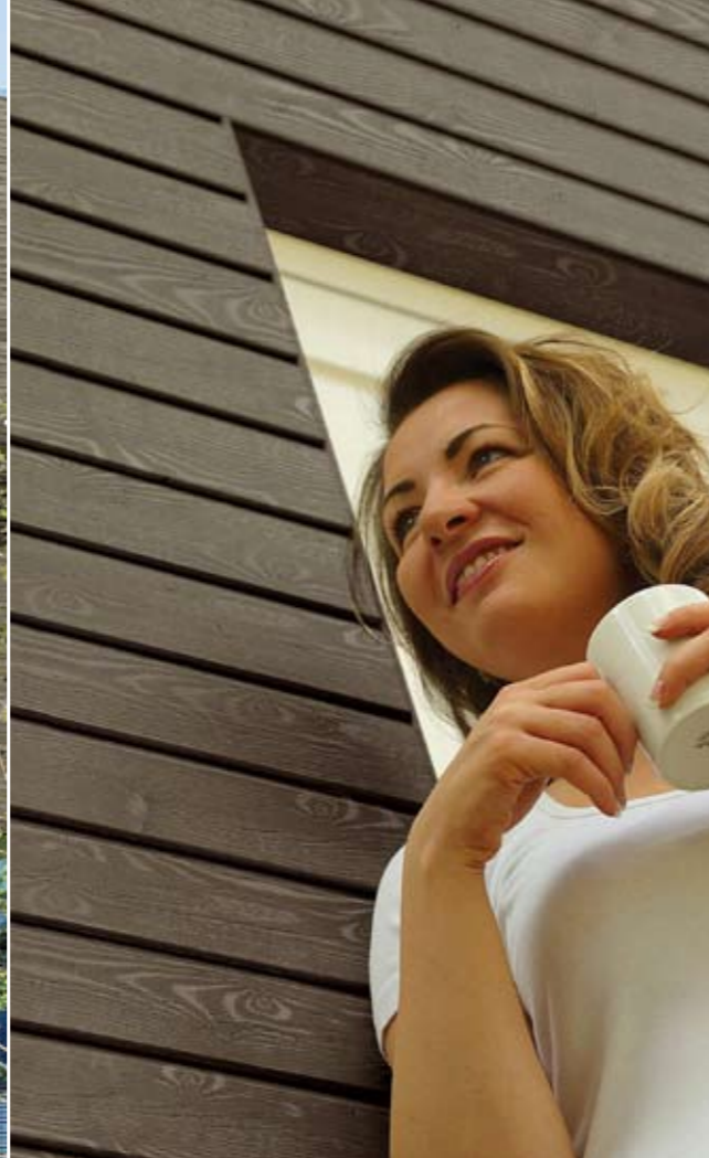
BU: Eine an allen Stellen gleichmäßige Patina ist das Ergebnis der Vorbehandlung mit der neu entwickelten Vergrauungslasur. Bild: tdx/Pinus
