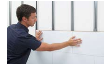
BU: Zuerst wird die Wand ausgemessen, danach werden die Montageprofile angeschraubt und schon kann mit dem Verlegen der Laminatdielen begonnen werden. Bilder: tdx/Classen
