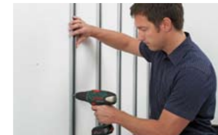
BU: Zuerst wird die Wand ausgemessen, danach werden die Montageprofile angeschraubt und schon kann mit dem Verlegen der Laminatdielen begonnen werden. Bilder: tdx/Classen
