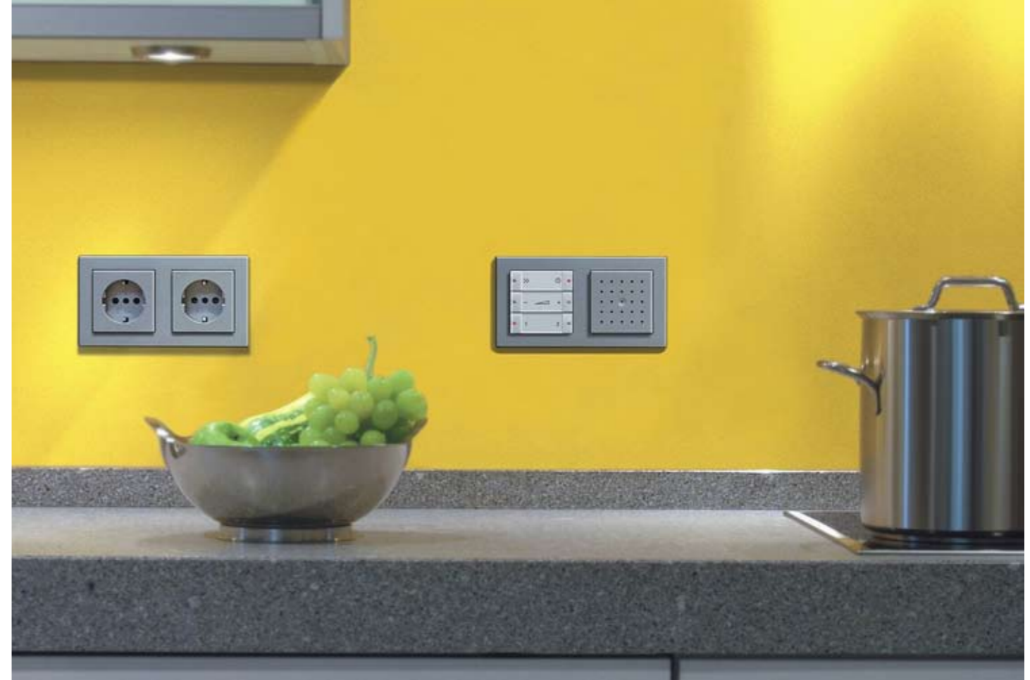
BU: In der Küche werden für Kühlschrank, Mixer und Co die meisten Steckdosen benötigt. Elektroinstallationen bieten Komfort: wie zum Beispiel dieses in die Wand integrierte Radio. Bild: tdx/Gira
